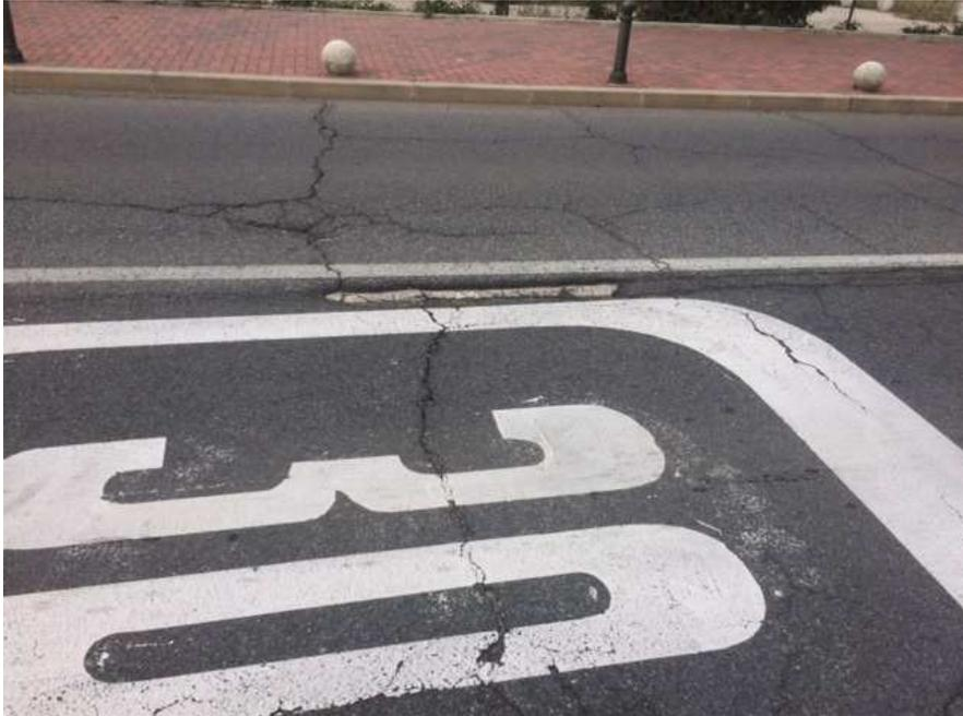
**Fotografía 3.** Tomada enfrente de la finca situada en el Paseo de la Ermita 51: Como se puede observar existe un bache con prolongación por juntas de dilatación creadas probablemente o bien por filtraciones de agua y posteriores dilataciones o por tránsito de vehículos pesados.
