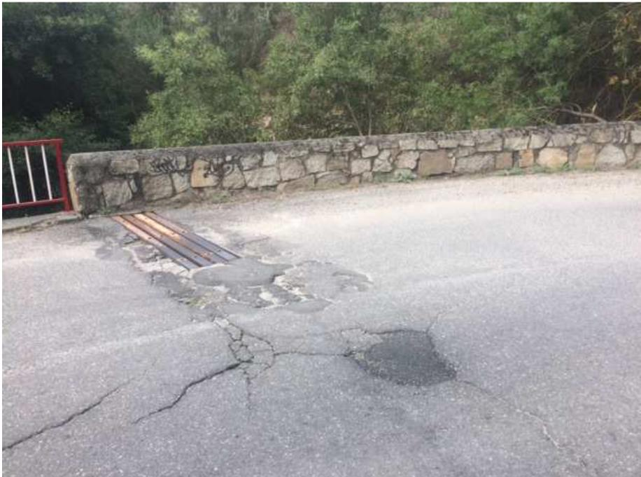
Como se puede observar existe una arqueta de recogida de aguas pluviales y varias reparaciones de pavimento y asfaltado que no han sido efectivas.
