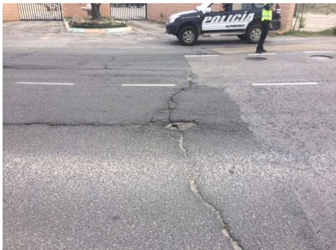
**Fotografía 2.** Tomada enfrente de la finca situada en el Paseo de la Ermita 53: Como se puede observar existe un bache con prolongación por juntas de dilatación creadas probablemente o bien por filtraciones de agua y posteriores dilataciones o por tránsito de vehículos pesados.
